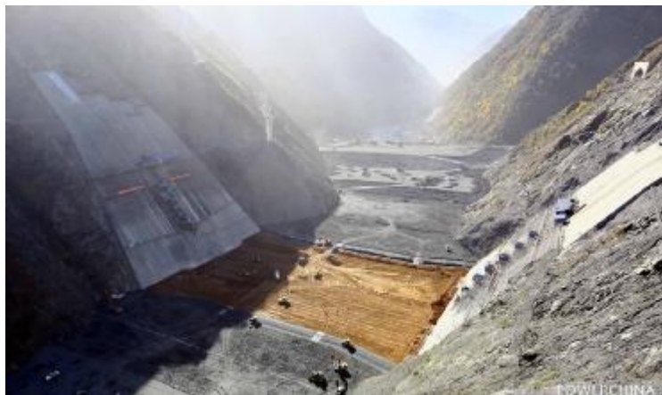
两河口水电站大坝填筑施工近貌
